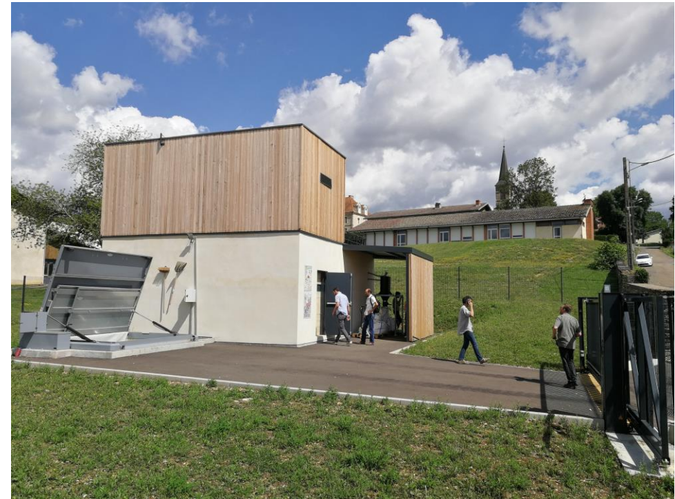
Chaufferie bois et réseau de chaleur « citoyens » - IME de Membrey (70)
