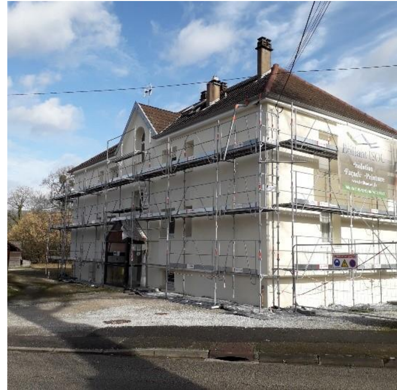
Réfection des enduits de façade du Foyer d'hébergement La Villa des Roses à Arbois (39) avec travaux embarqués d'isolation thermique par l'extérieur
