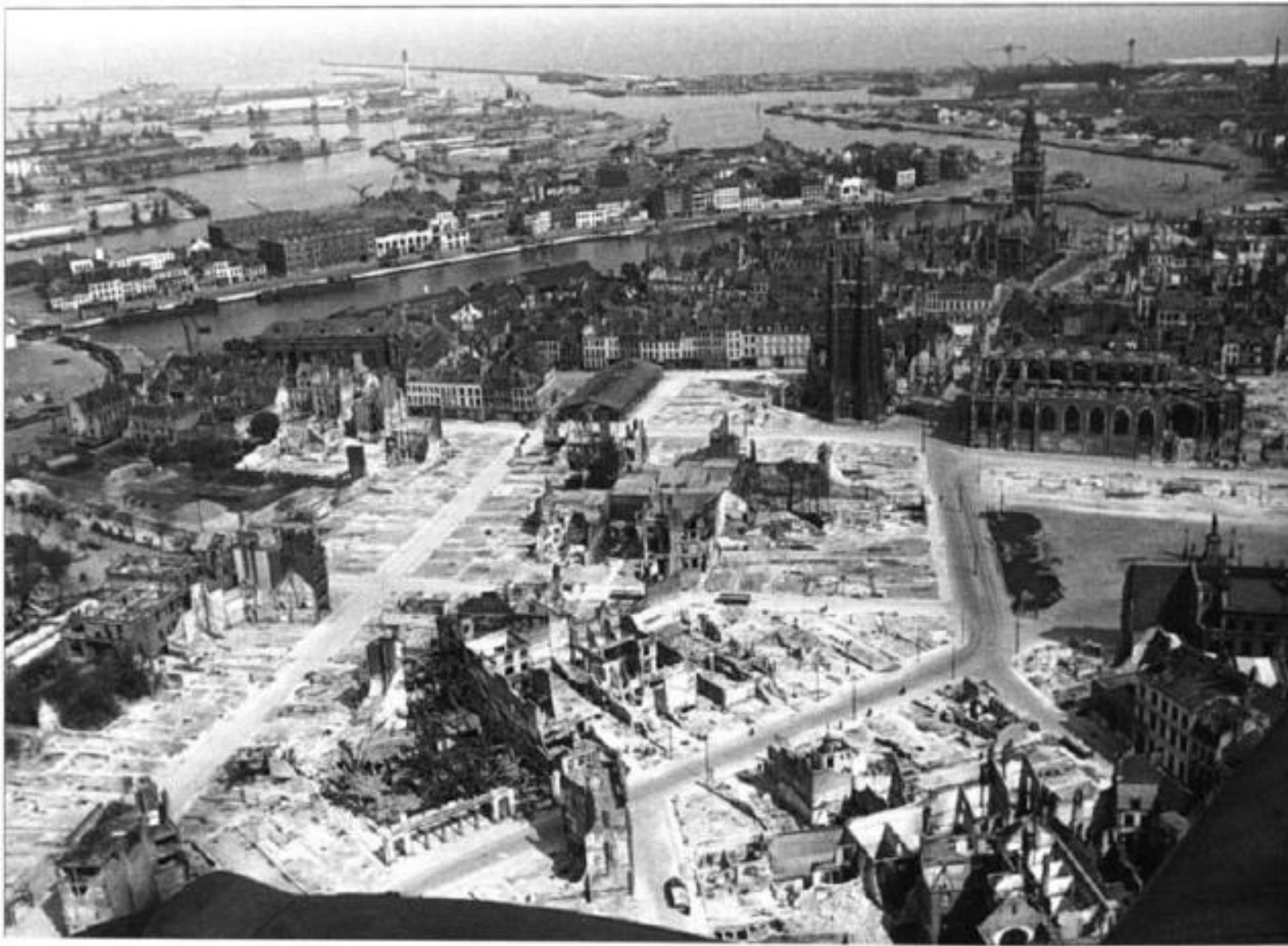
Le centre-ville de Dunkerque en 1945
