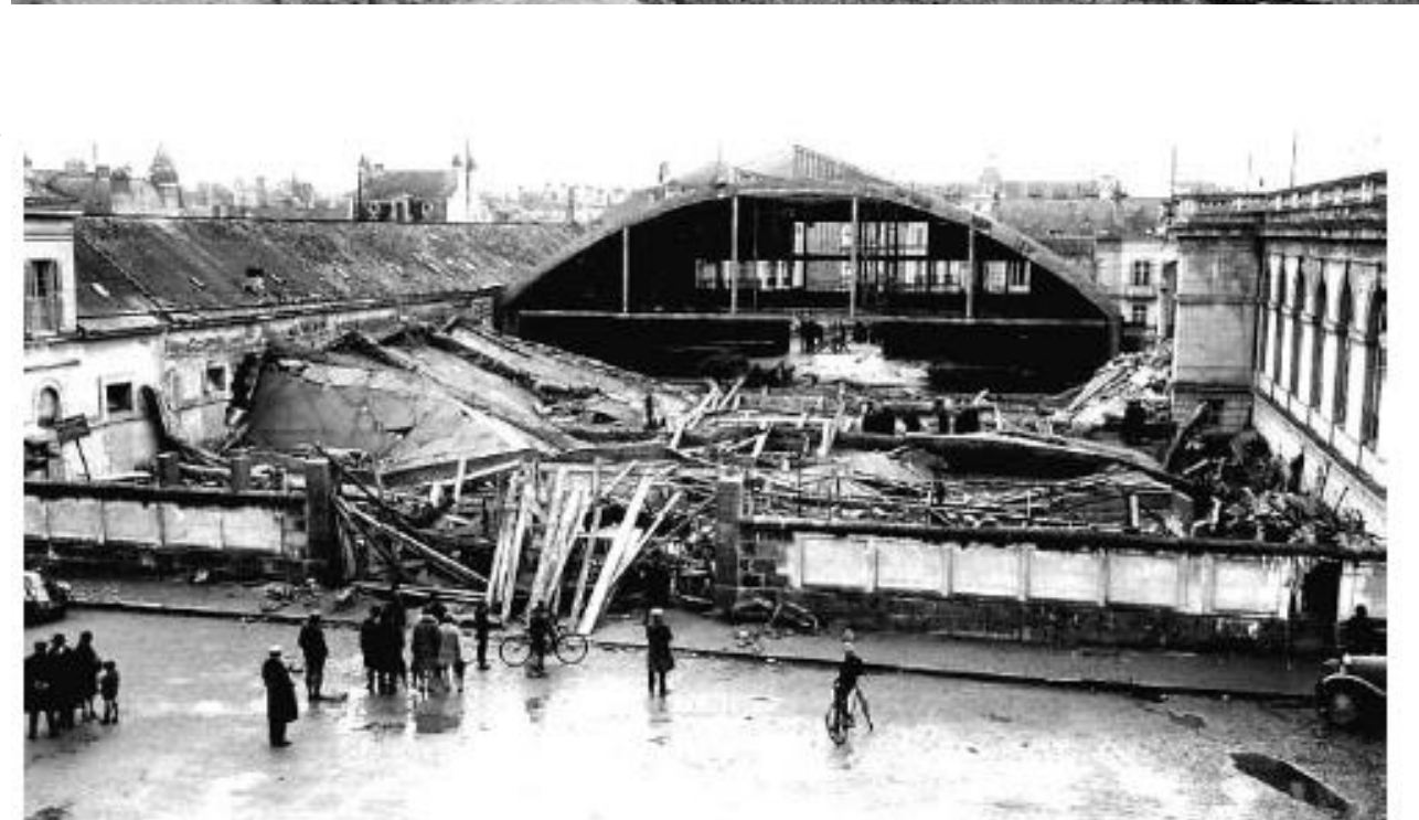
24 Décembre 1928 : Effondrement d'un garage causé par un décoffrage prématuré (7 morts, 2 blessés graves)
