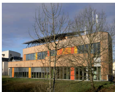
Maison des énergies Héricourt
